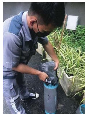
เจ้าหน้าที่เปลี่ยนถ่านตัวกลางระบบมีเทน และ Aerosol
