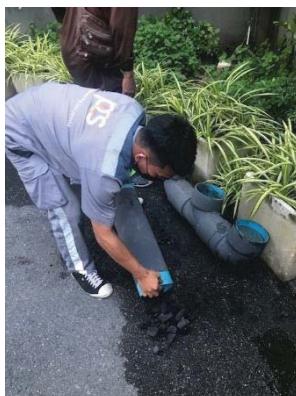
เจ้าหน้าที่เปลี่ยนถ่านตัวกลางระบบมีเทน และ Aerosol
